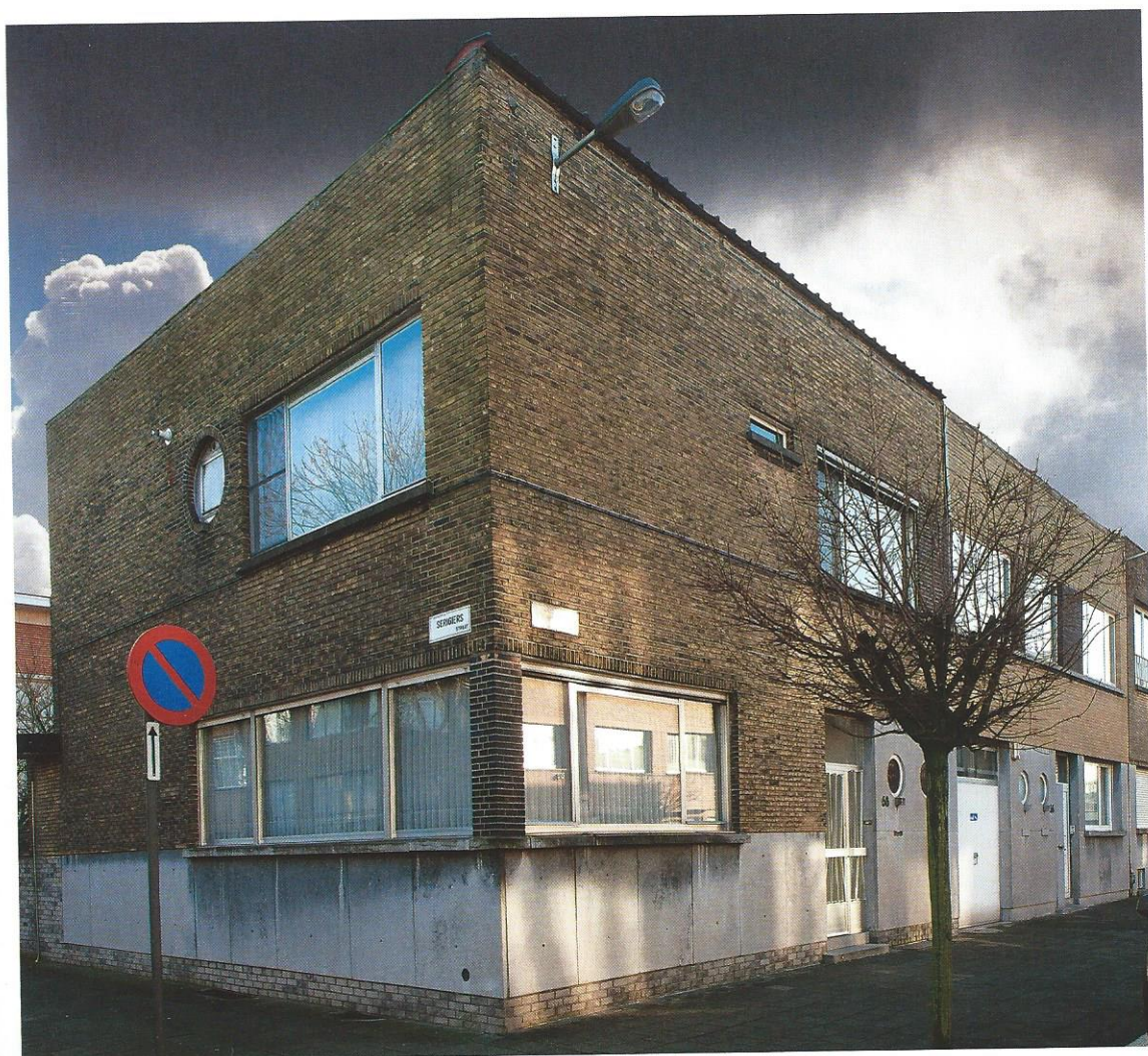
De hoekwoning Van Laethem met dakterras en woning Hirsch (foto O. Pauwels)
